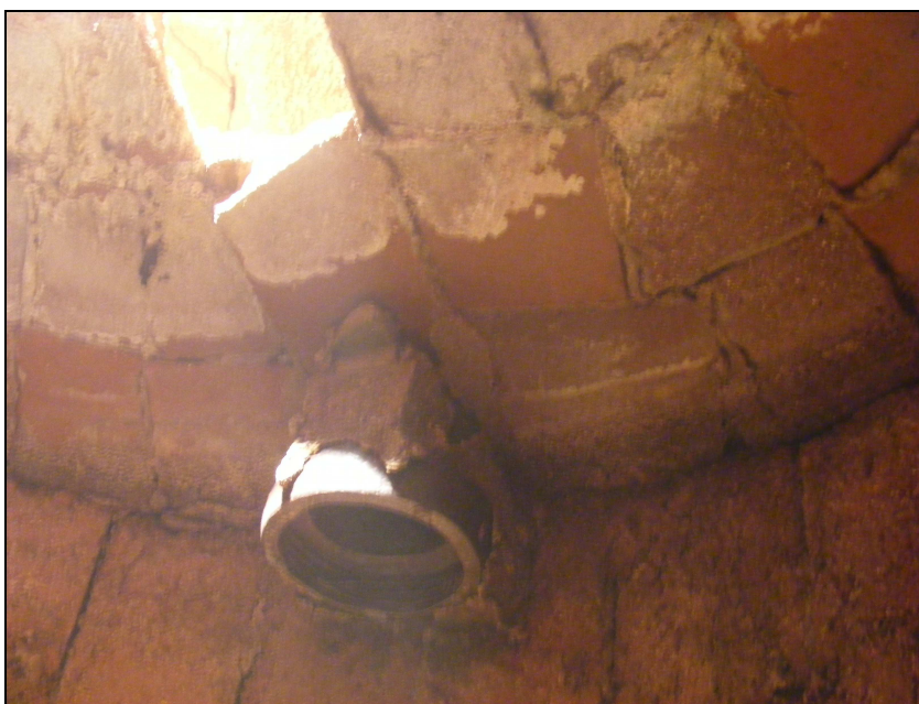
Fig. 25.- Detall del sobreexidor .
