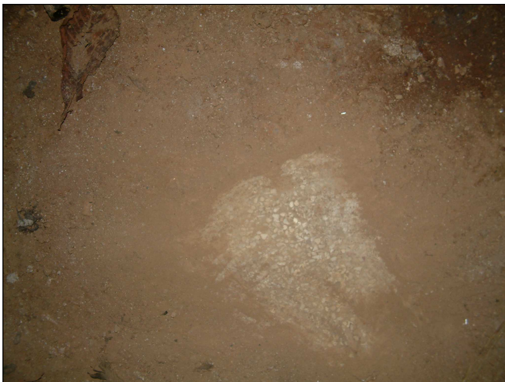
Fig. 7.- Paviment existent al soterrani.
