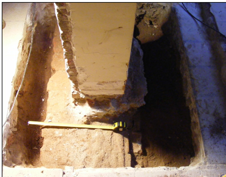
Fig. 6.- Vista final del sondeig 1.
