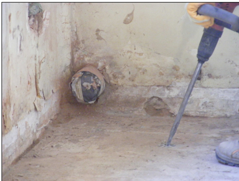
Fig. 16.- Vista inicial del sondeig 5.
