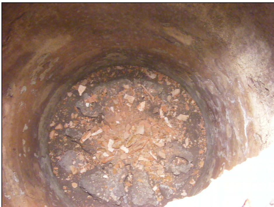
Fig. 24.- Aspecte interior del pou mort.
