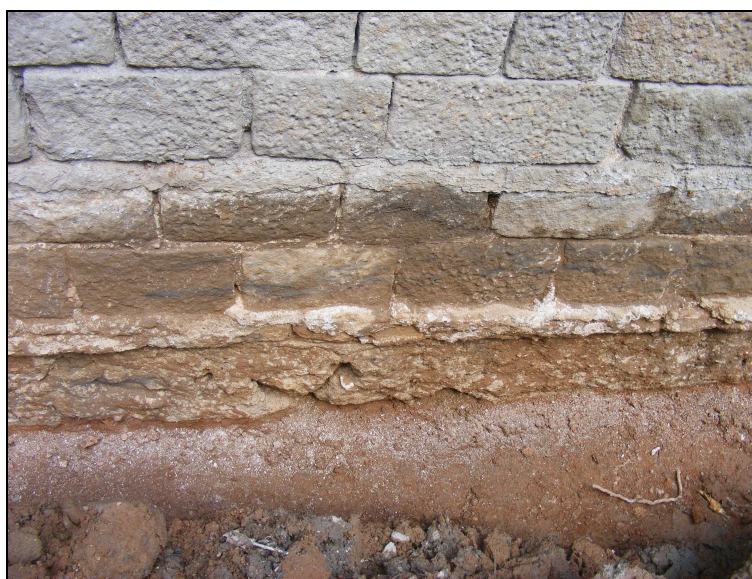
Fig. 32.- Detall de la diferència entre el sòcol de pedra (u.e. 1004) i la fonamentació (u.e. 1013).
