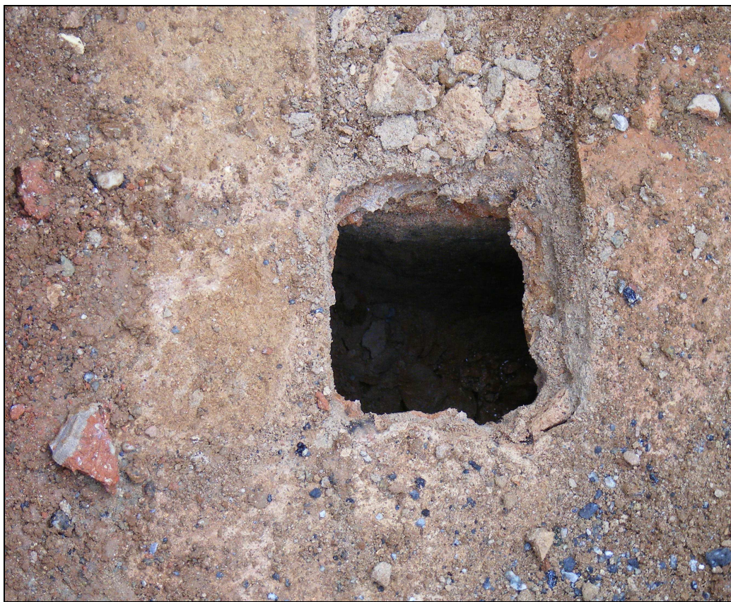
Fig. 12.- Detall de l'obertura a la tapadora per documentar l'existència de la claveguera u.e. 307.
