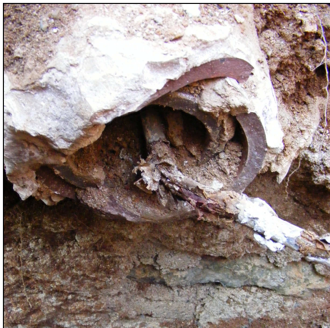
Fig. 36.- Detall del tub de serveis localitzat a la façana est.
