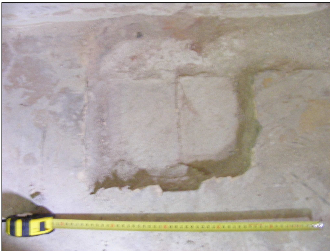
Fig. 21.- Detall de la canalització u.e. 705.
