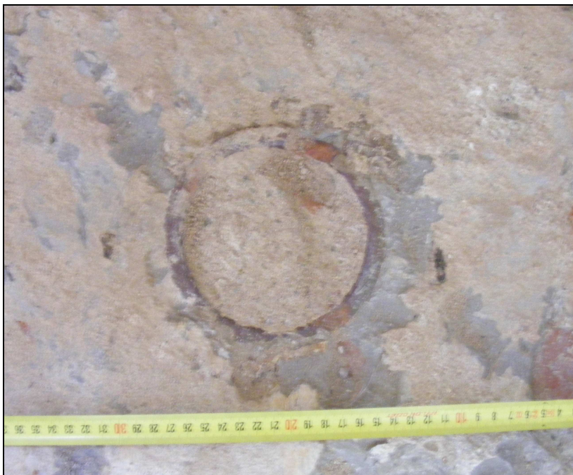
Fig. 17.- Detall del desguàs u.e. 505.
