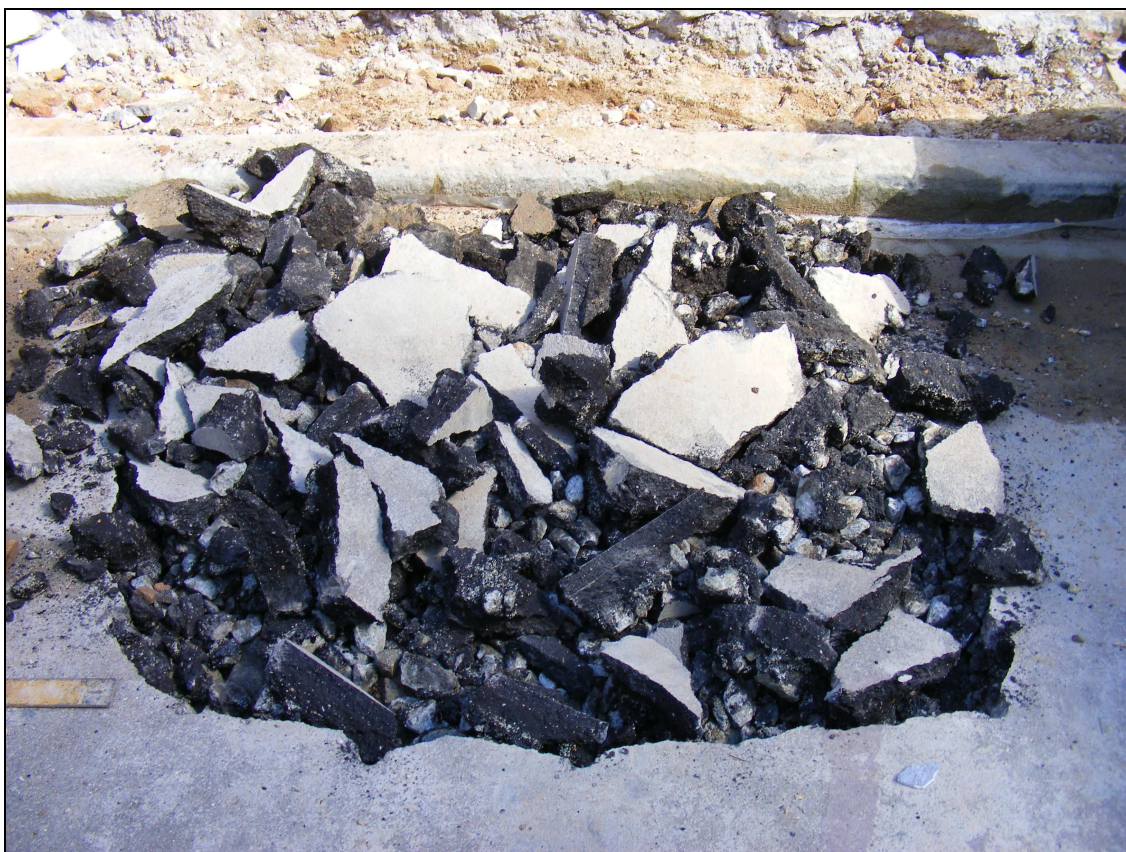
Fig. 9.- Procés d'afectació de les u.e.'s 301 i 302.
