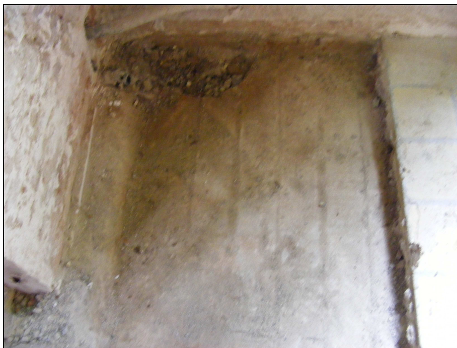
Fig. 26.- Detall del paviment lliscat u.e. 405 entregant-se a la pilastra oest i a la seva balustrada.
