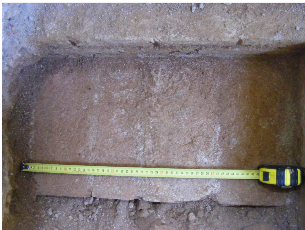
Fig. 27.- Detall de la canalització u.e. 508.
