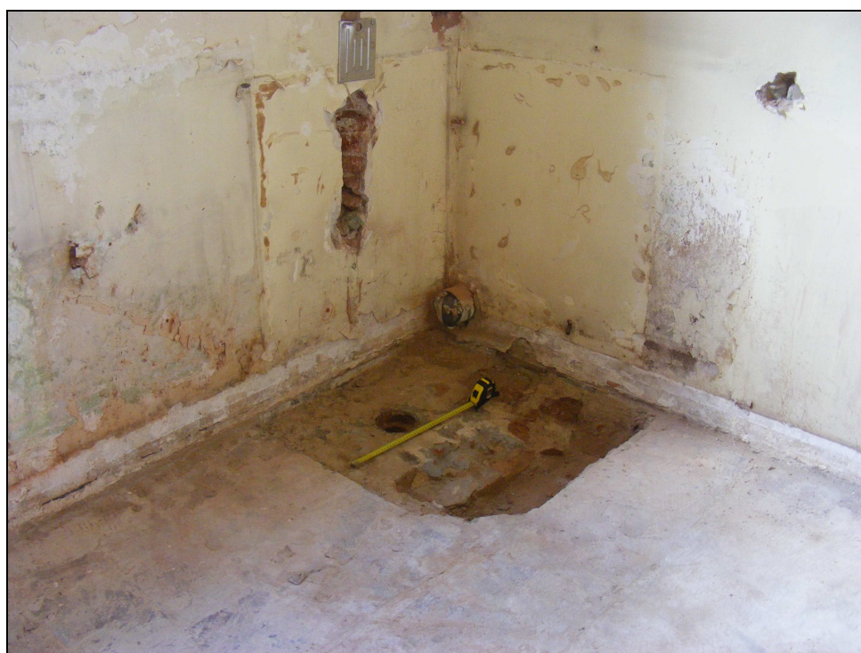
Fig. 18.- Vista final del sondeig 5.
