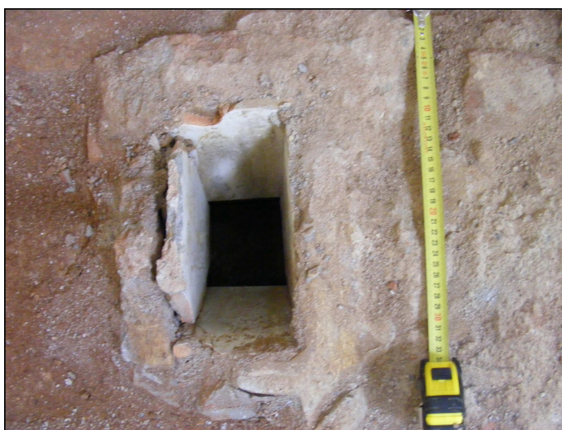
Fig. 28.- Detall del desguàs u.e. 507.
