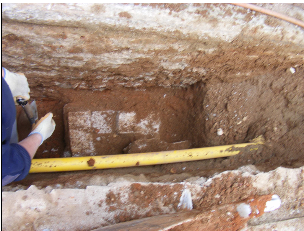
Fig. 38.- Detall del tub u.e. 1009.
